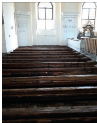
Trámy po vyčištění a napuštění lakem
