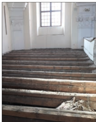
Trámy po vytrhání staré podlahy
