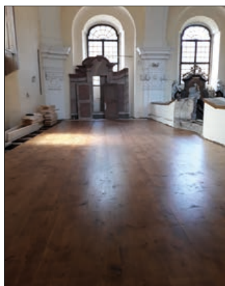
Podlaha po napuštění a finální povrchové úpravě
