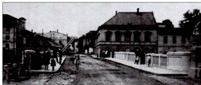
Obr. 4: Klokocovský most je již hotov, vozovku ještě čekají úpravy
