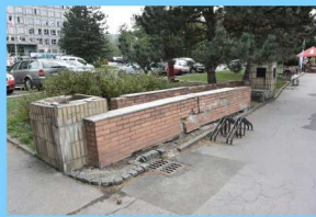
Pozůstatek výstupu z CO krytu
