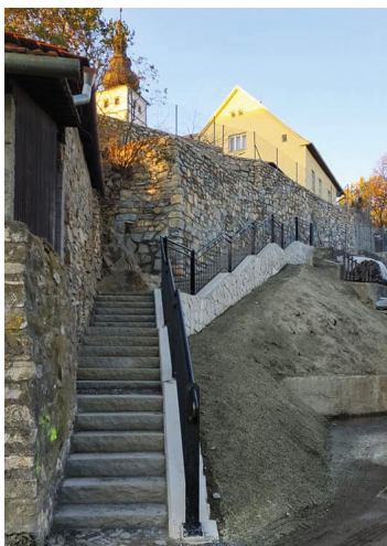
rekonstruovaná ulička spojující ulice Farní a Žižkovu a nová ohradní zeď (foto: P. Netušil)
