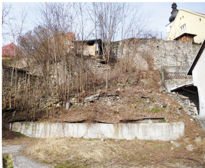
Původní stav uličky a opěrné zdi
