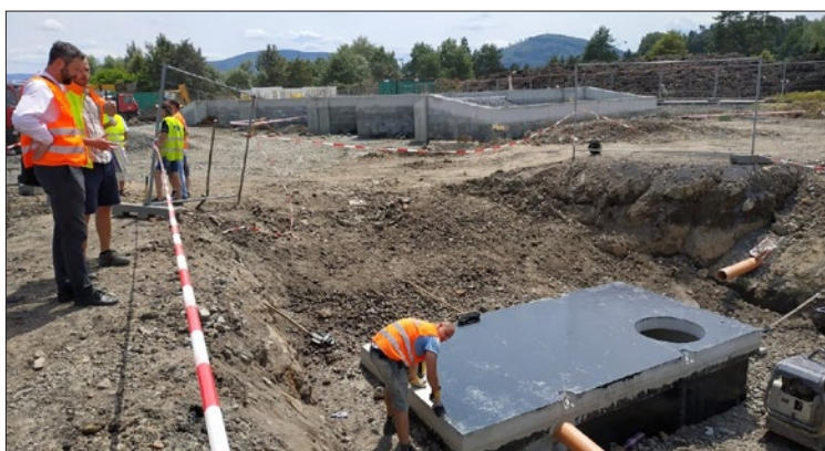
Starosta města Jan Malík sleduje práce na retenční nádrži, která bude zachytávat dešťové vody z prostoru nové budovaného sběrného dvora u kompostárny. Foto: Pavel Netušil
