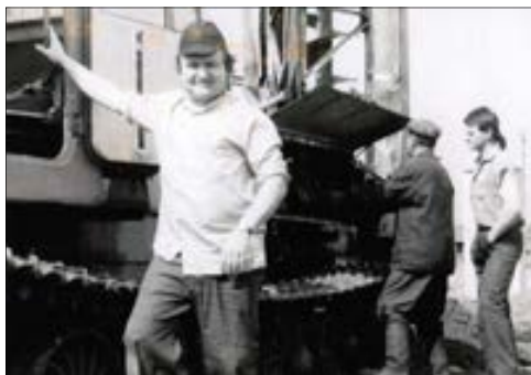
Foto: Karel Greiner při navrtávání sloupu rozvodny plynovodu v Rjažanské oblasti v Rusku, 23. 4. 1990. Soukromý archiv Karla Greinera
