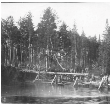
Stavba spalenišho polivského mostu přes řeku Pojmu a Kaseřova - červen 19
