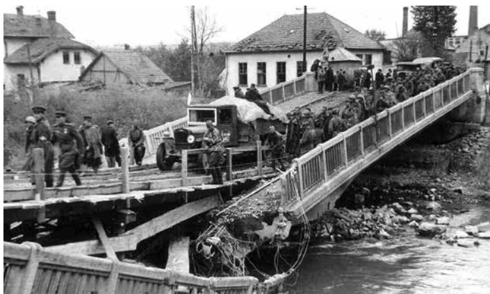
Klokočovský most byl ještě 6. 5. 1945 provizorně opraven.
